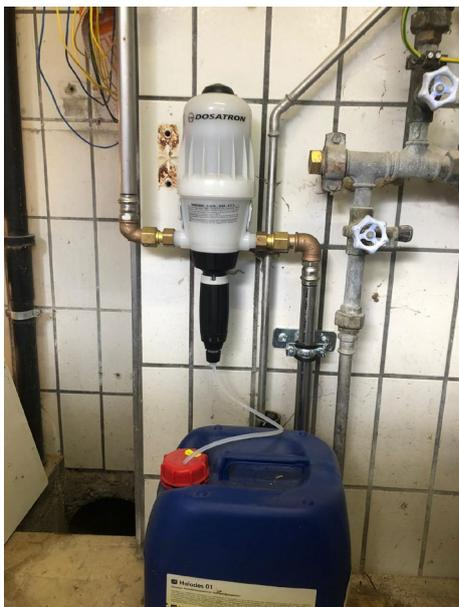
Dosatron® pour le dosage d'une petite quantité de désinfectant, afin de stabiliser l'eau d'abreuvoir.
